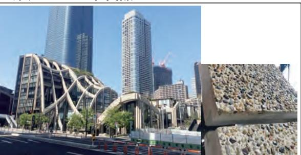
GRCとは、セメントまたはセメントモルタルを耐アルカリガラス繊維で補強した、ガラス繊維補強セメントの略称で、引張強度及び韌性に劣る無機質セメントを、引張強度に優れたガラス繊維で補った複合材料を使用した製品であり、用途は建築(内外装)・土木や景観材料(モニュメント・擬岩等)と幅広い。
