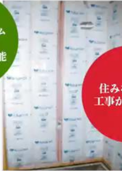
袋入り断熱材の施工例
