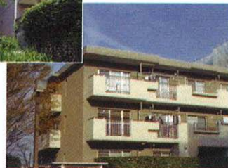
一部足場が撤去された7号棟
