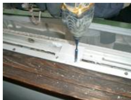
2 下地材 取付け
