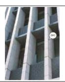
GRCとは、セメントまたはセメントモルタルを耐アルカリガラス繊維で補強した、ガラス繊維補強セメントの略称で、引張強度及び靱性に劣る無機質セメントを、引張強度に優れたガラス繊維で補った複合材料を使用した製品であり、用途は建築(内外装)・土木や景観材料(モニュメント・擬岩等)と幅広い。
