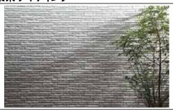
窯業系サイディングは8割強の新築住宅で使われているセメントを 主原料とした板状の外壁材である。最近では、介護、文教施設等の 中低層の施設でも採用が進んでいるセメント質原料、繊維質原料 等を成型、養生硬化して生産された製品は日本産業規格JIS A 5422 に規定された、防火性能に優れ、強くしなやかで色・柄の品揃 えも豊富である。
