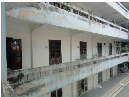
VIBM 内部外観
