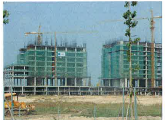
建設中の行政センター(2013年までに移転予定)
