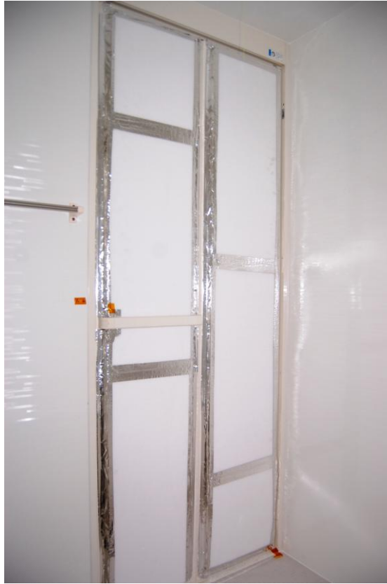
写真-3 扉の浴室側の内材部分に厚さ 25mm の EPS を貼り付けた状態
