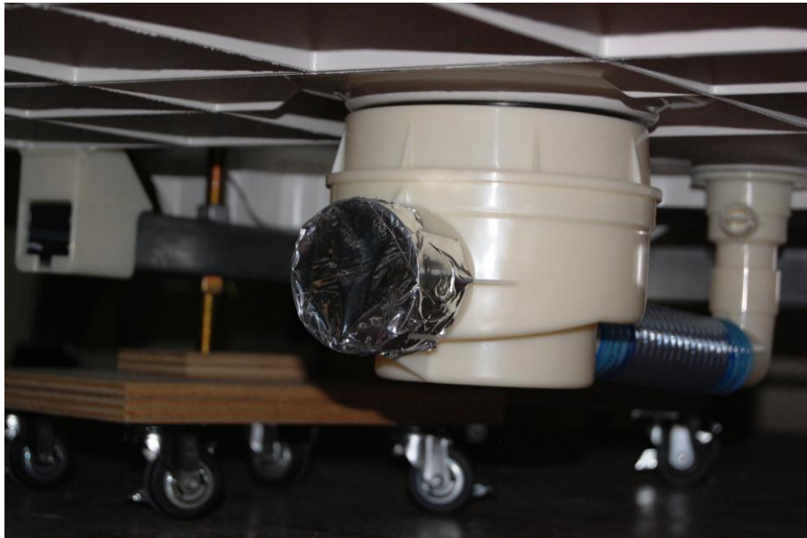
写真-1 排水口をアルミテープで塞いだ状態
