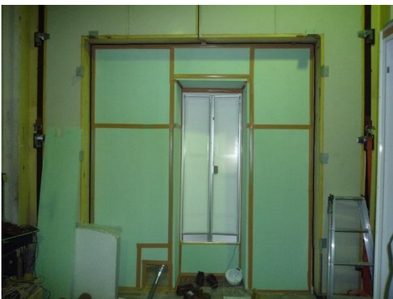
写真五 浴室ユニット扉部分
