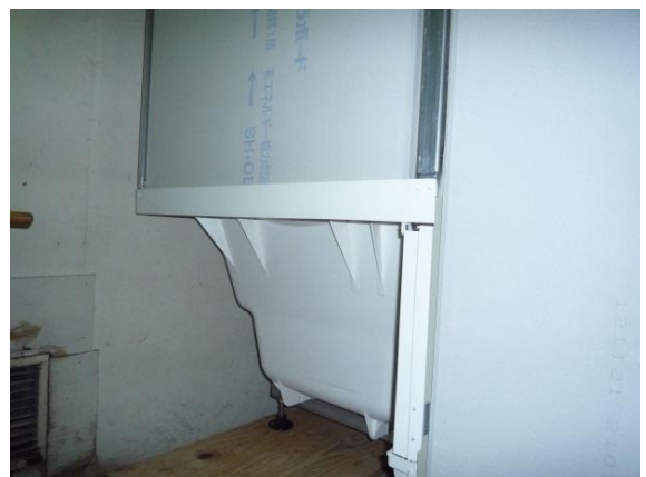
写真六 浴室ユニット外部 (断熱なし)
