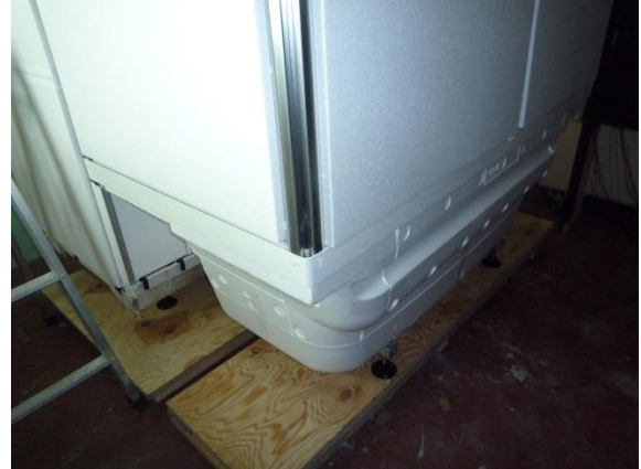
写真四 浴室ユニット外部 (断熱あり) 2
