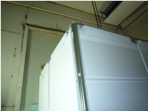
写真三 浴室ユニット外部 (断熱あり) 1
