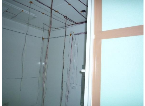
写真二 浴室ユニット内部 2
