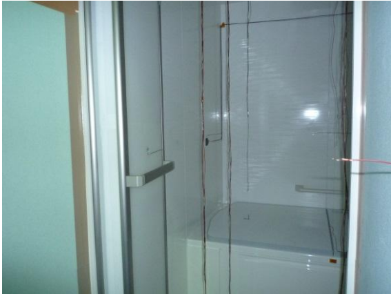
写真一 浴室ユニット内部 1
