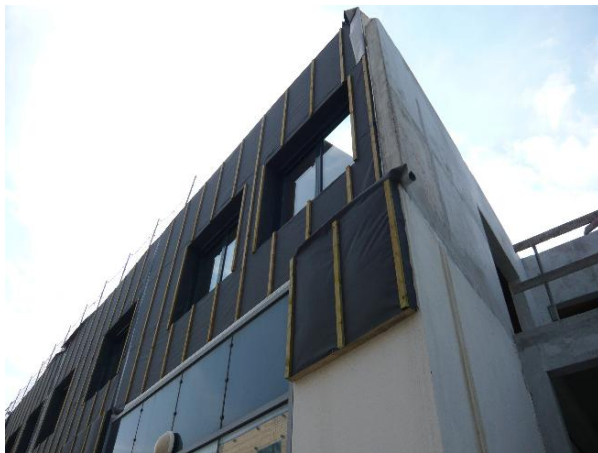
図 5.3.7—住宅外壁施工現場（通気層）
