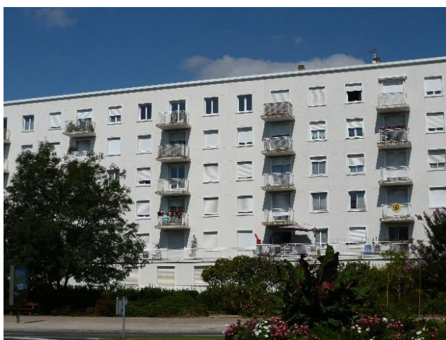
図 5.3.5ーラロッシュェルの集合住宅のシャッター付き窓 (樹脂スラット)
