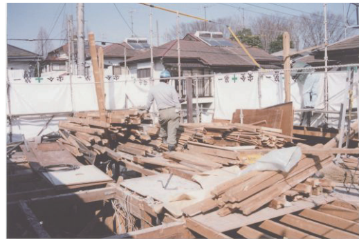
図 2.2.38 躯体材の集積状況
