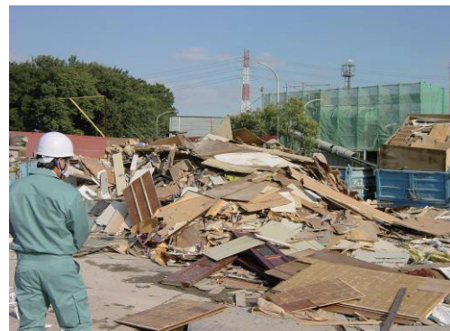
図 2.2.51 解体現場より搬入された合板類
