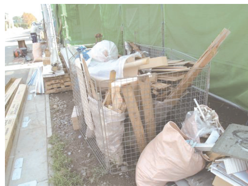
図 2.2.31 現場保管場所建設廃棄物集積状況
