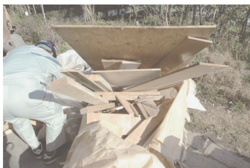
図 2.2.45 合板類、板材の端材
