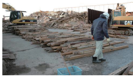
図 2.2.73 躯体材からの異物除去作業
