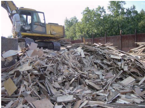
図 2.2.53-1 木屑破碎ライン投入前(合板類、小角材)
