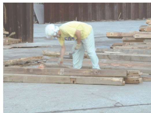
図 2.2.24 釘抜き作業
