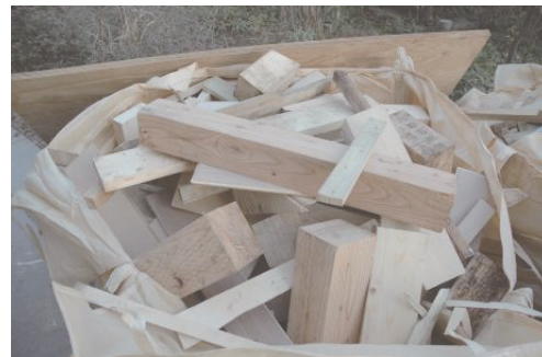
図 2.2.44 躯体材、小角材の端材
