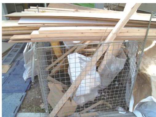
図 2.2.32 小角材、合板類の端材
