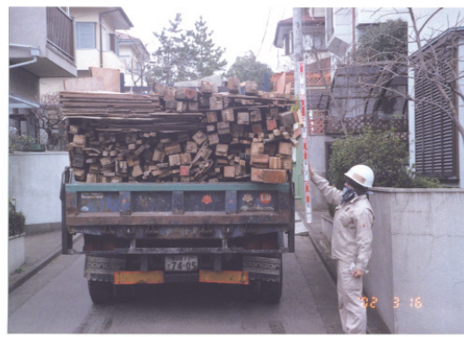
図 2.2.42 躯体材、合板類の搬出
