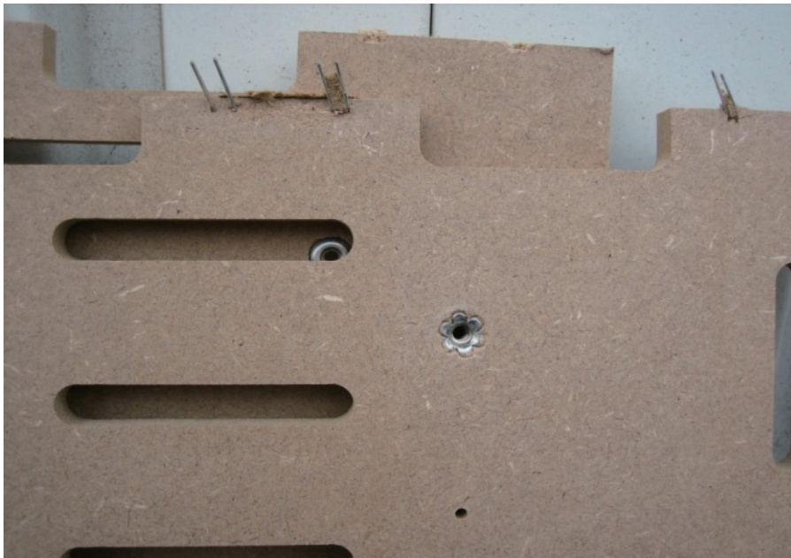
図 3.3.7 パチスロ解体材への金属類の付着・残存状況
