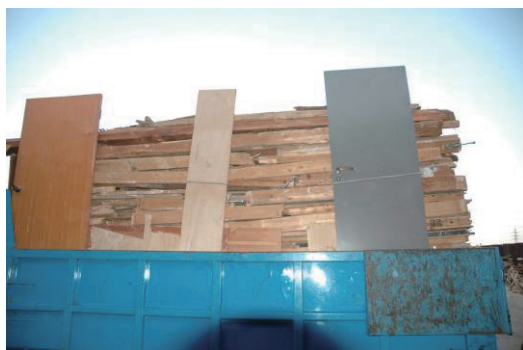
図 2.2.68 搬入状況(躯体材に金物類が目立つ)
