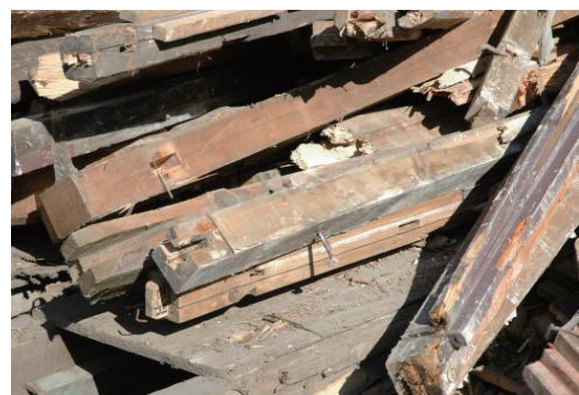
図 2.2.105 躯体材の集積
