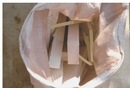
図 2.2.35 ガラ袋に小角材の端材
