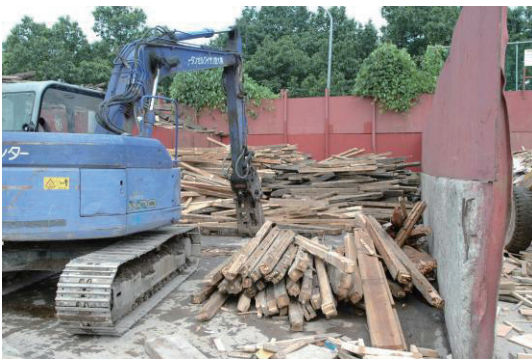
図 2.2.50 解体現場より搬入された躯体材
